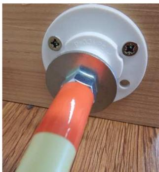
Falls Leckagen durch den Injektionsschlauch 12/6 injiziert werden müssen, den Stopfen zum Schutz der Injektionsbohrung entfernen, den Schmiernippel aufschrauben und mit einem Schlauch mit 4-Backen Greifkupplung dichtend injizieren.
